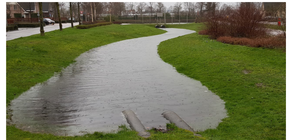
3. Bassin infiltrant (WADI) Infiltratie bekken (WADI)
