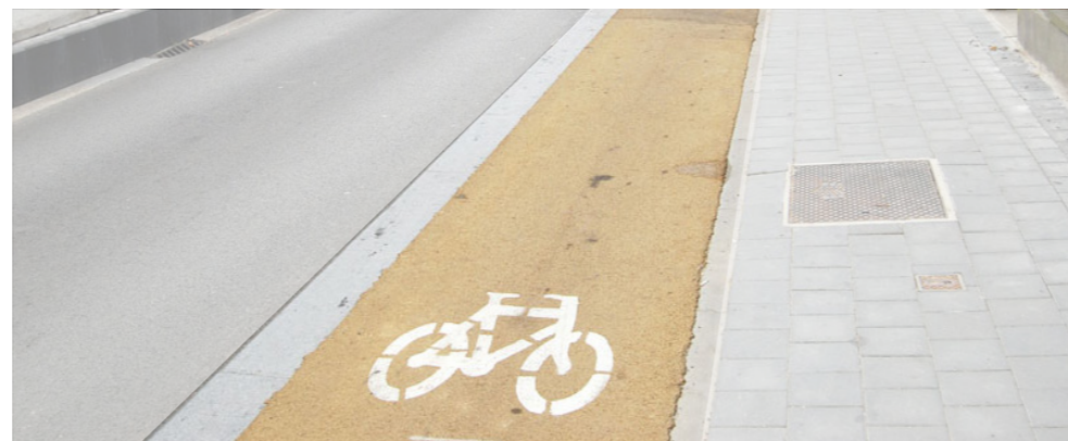
2. Gekleurd asfalt (oker) Asphalte coloré (ocre)
