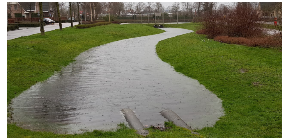
3. Bassin infiltrant (WADI) Infiltratie bekken (WADI)
