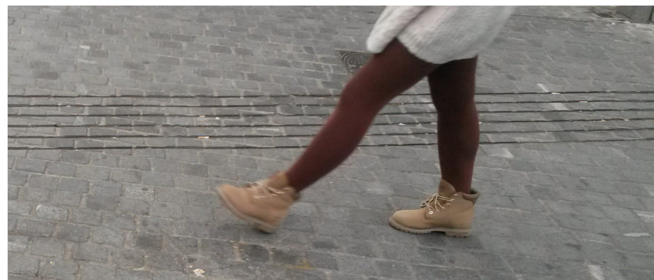
1. Blindegeleidelijnen gezaagd in de verharding Dalles podotactiles scié dans le revêtement
